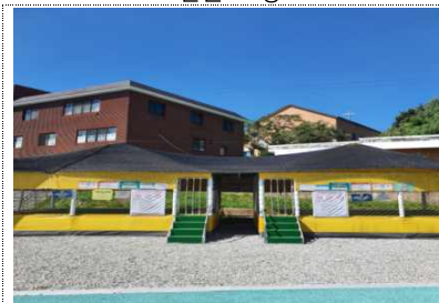
* 야외 방방이(트램펄린) 그늘막 설치
