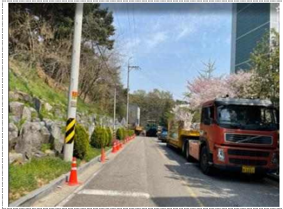
인도 공사 전
