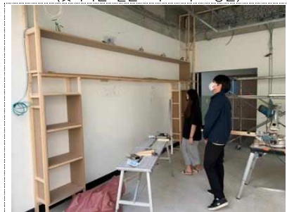
카페테리아 공사 현장 확인
